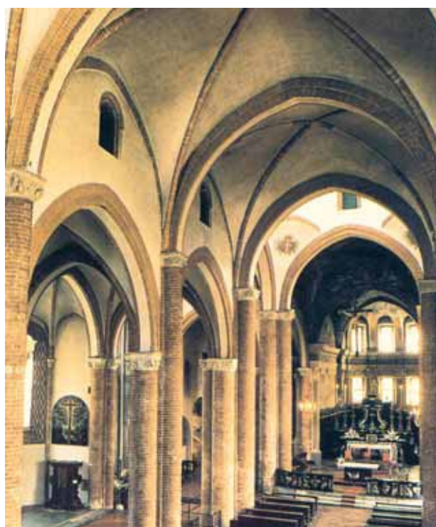
Interior del Colegio de San Segundo
