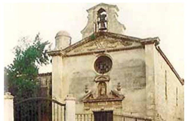
Façade de la chapelle des Pénitents Gris
